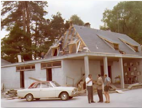
Dacharbeiten vor fast 60 Jahren
