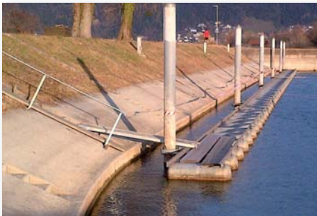
Stufe 1 der Stegsanierung: Norddamm-Steg von Geh-Brettern befreit
