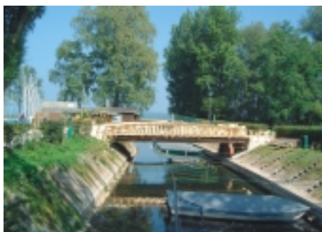
Der Brückenschlag über den Subersbach
